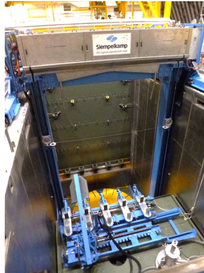
Blick in das Einbautenbecken, Installation der Hilfseinrichtungen zur Zerlegung
