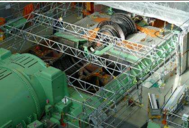
Impressionen der Rückbauarbeiten im Maschinenhaus: Demontage Turbogruppen und Vorwärmerstrassen
